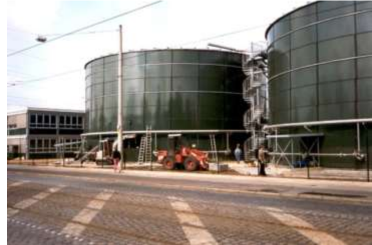
Сооружения предварительной очистки стоков пивоварни BECKs в Бремене, Германия, эксплуатируются городским оператором
