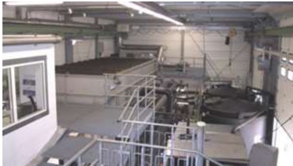
Флотация на стадии предварительной обработки, Реда-Виденбрюк, Германия
