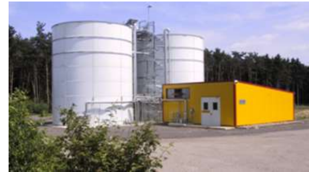
Уравнительный резервуар и смеситель, производства мармелада Göbber, Германия
